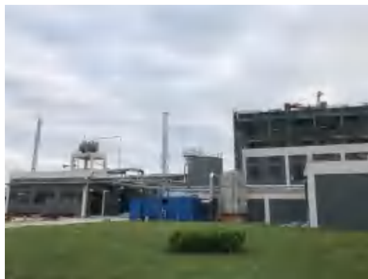
锅炉房和污水处理站
