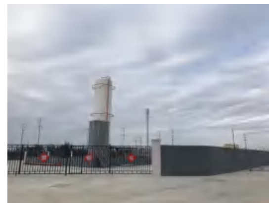
LNG 储罐区（未启用，计划拆除）
